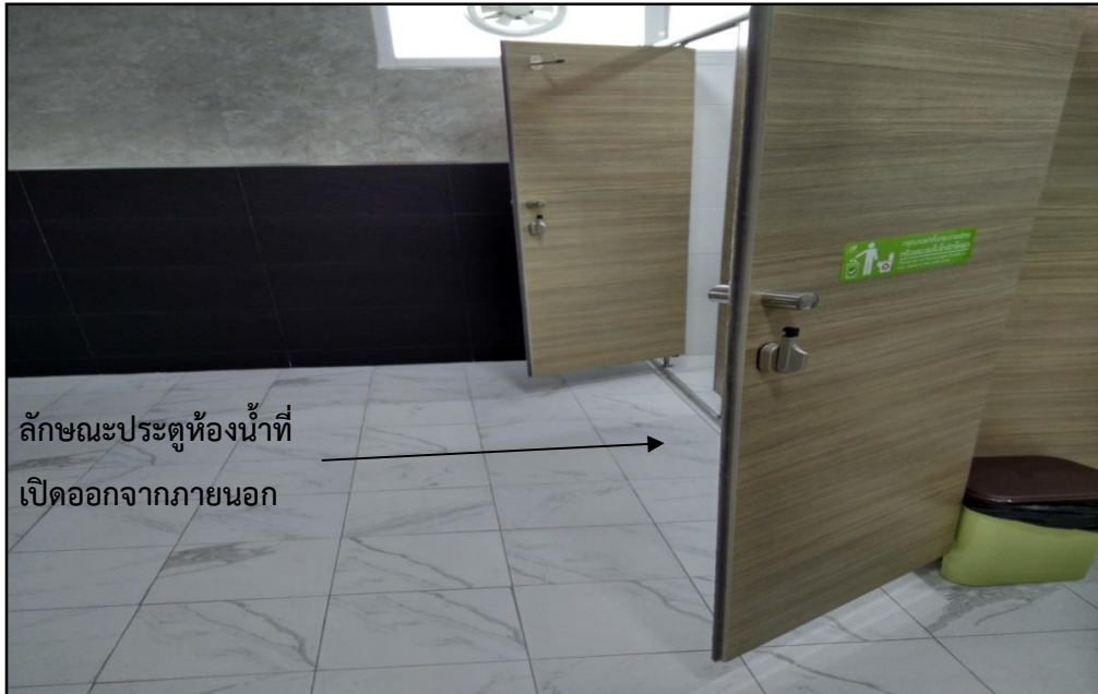
ภาพที่ 5.4 ลักษณะประตูห้องน้ำที่เปิดออกจากภายนอก
