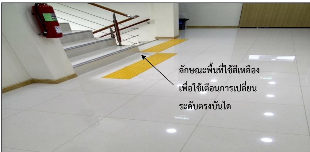
ภาพที่ 5.9 ลักษณะพื้นที่ใช้สีเหลืองเพื่อใช้เตือนการเปลี่ยนระดับตรงบันได
